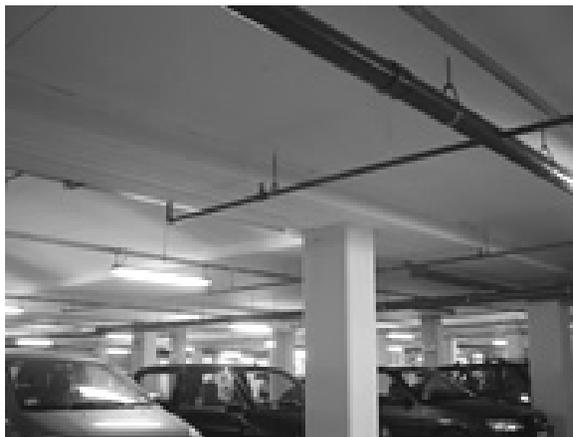
L'erogazione di acqua può essere comandata da un impianto di rilevazione - incendi, oppure essere provocata direttamente dalla apertura delle teste erogatrici: per fusione di un elemento metallico o per rottura, a determinate temperature, di un elemento termosensibile a bulbo che consente in tal modo la fuoriuscita d'acqua.
